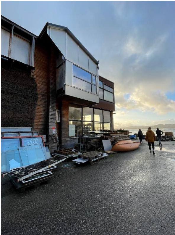
Obr. č. 1_Bergen School of chitecture v Bergene (BAS), exteriér
