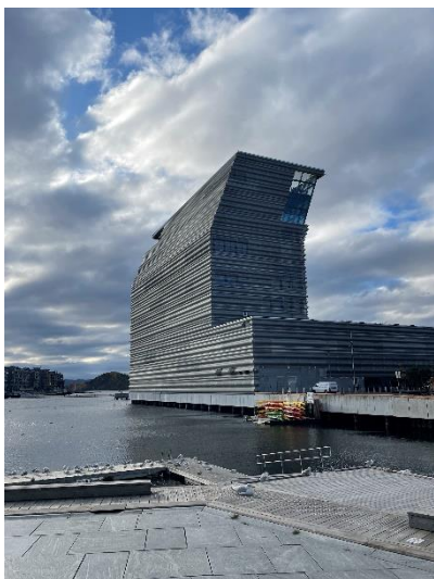
Obr. č. 31_ Oslo, MM, pohľad z prístavu
