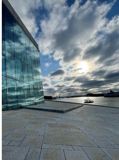
Obr. č. 22_ Oslo Opera House, pohľad z nástupnej plošiny strechy
